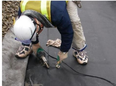
写真 2.1-2 手動式熱風融着機
