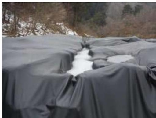
写真 3.5-1 腐敗後の不同沈下の様子
