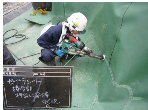
写真 2.4-5 押し溶接状況
