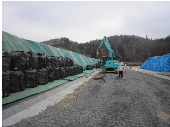
写真 2.4-6 大型土のうによる仮押さえ状況
