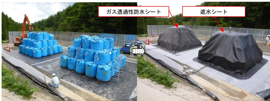
写真 3.1-1 フレコン段積み状況(左)と上部シート設置(右)
