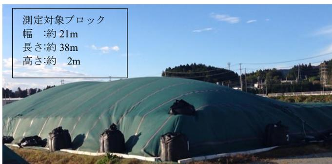
写真 3. 4-5 風によるガス透過性防水シートの変形
