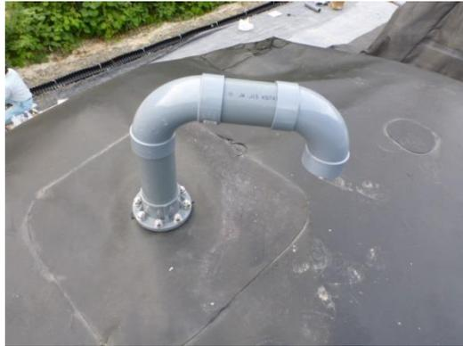
写真 2.3-1 PVC 管（塩ビ管）フランジ固定例
