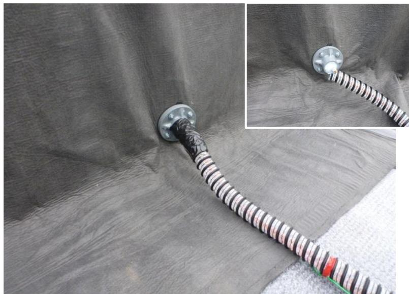
写真 2.3-2 シート貫通ケーブル設置状況
