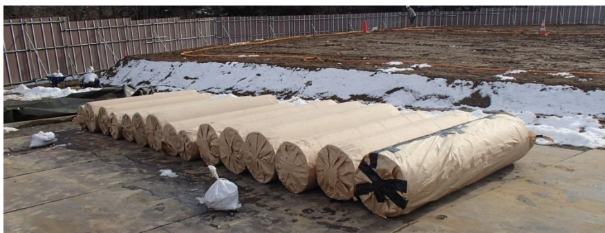
写真 2.1-4 シート搬入状況（荷姿）
