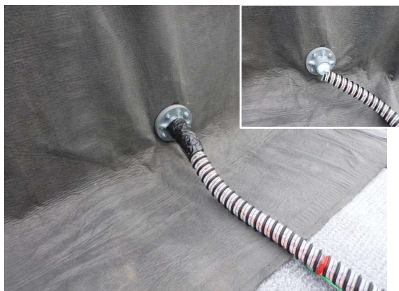
写真 2.3-2 シート貫通ケーブル設置状況
