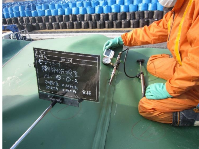
写真 2.4-7 加圧検査状況
