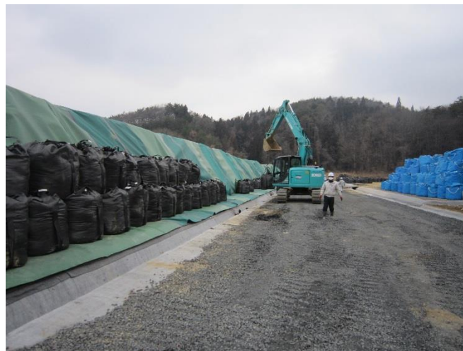
写真 2.4-6 大型土のうによる仮押さえ状況
