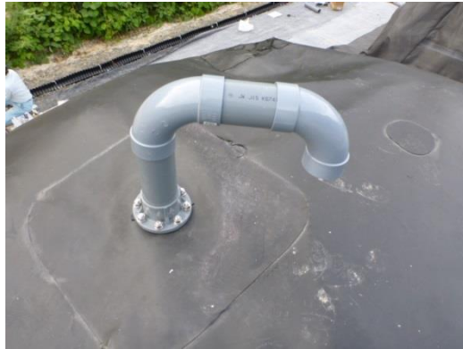
写真 2.3-1 PVC 管（塩ビ管）フランジ固定例
