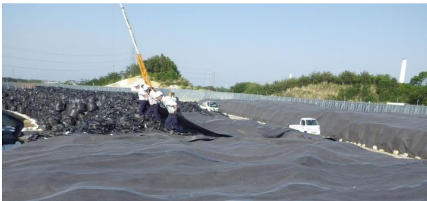
写真 2.1-9 シート敷設状況
