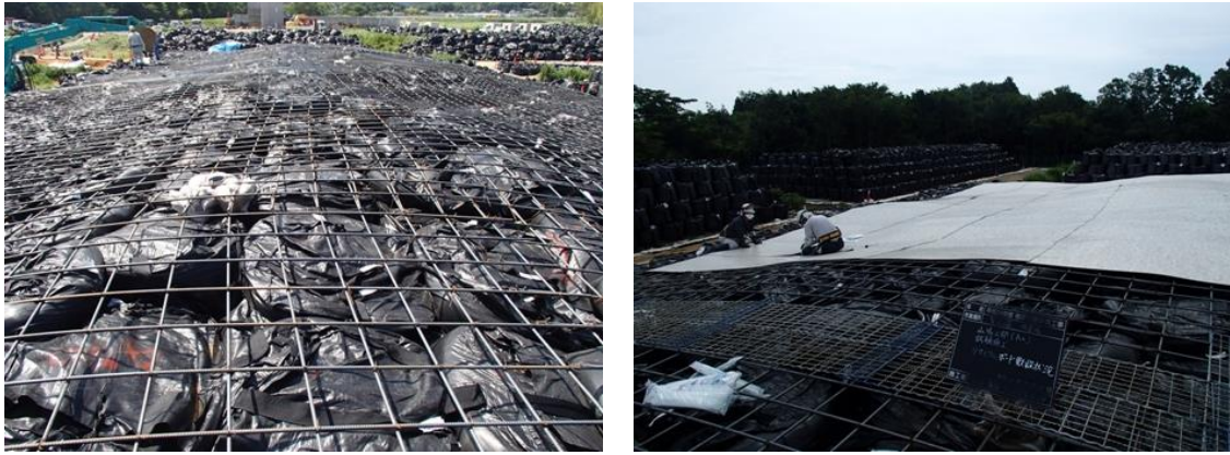
写真 2.3-3 鉄筋メッシュ+リサイクルボード設置状況
