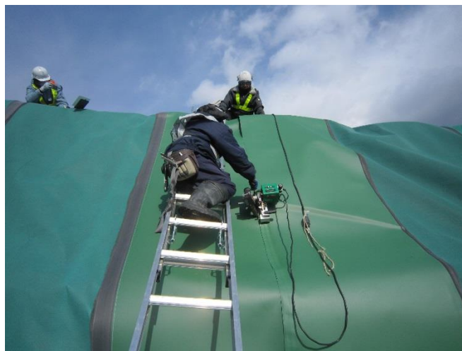
写真 2.4-3 現場接合部自走式融着状況
