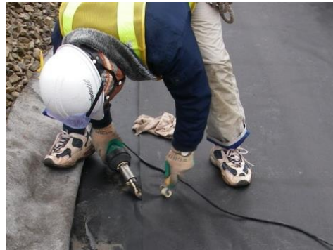
写真 2.1-2 手動式熱風融着機
