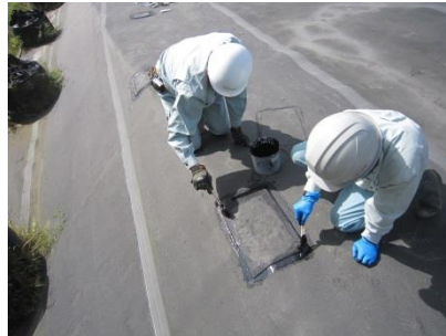
写真 2. 2-6 外周端部の塗布 (手順⑮)
