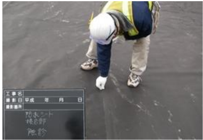
写真 2.1-7 接合部触診確認
