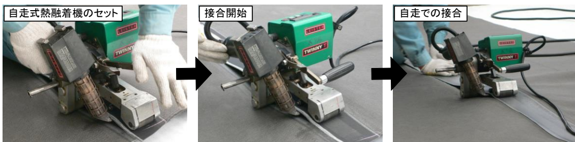
写真 2.1-6 自走式熱融着機による融着状況
