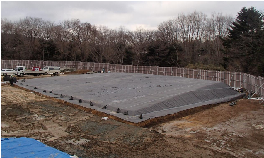
写真 1.1-4 ガス透過性防水シートを上部シートとして敷設した除染廃棄物仮置場
