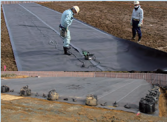
現場で溶着作業が可能です
