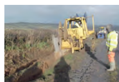
ケーブル保護工
