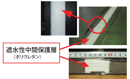
接合部ポリウレタン注入後の状況
