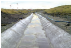
三面張水路工 (大断面)
