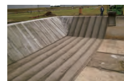
コンクリート補修工
